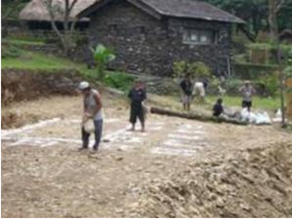
(圖 10):放樣、挖地基
